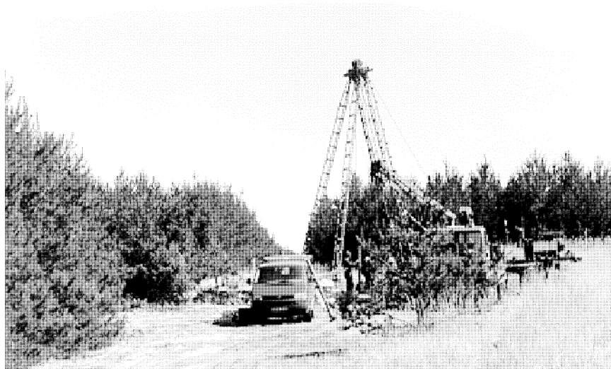
Abb. 4.1-2 Installation des Multilevelpegels SGM 1
